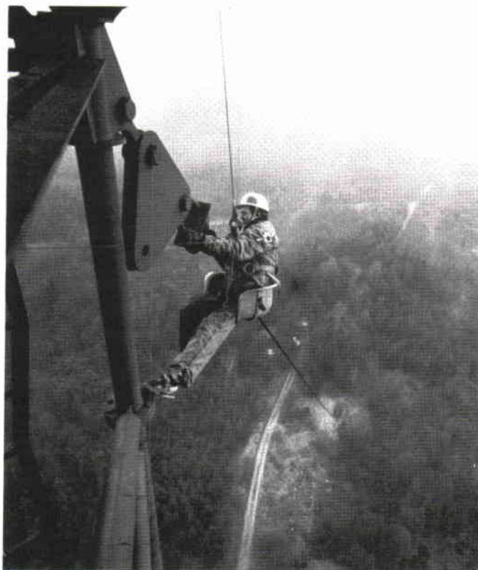
Mekaniskt underhåll Spaningsradar PS-15
